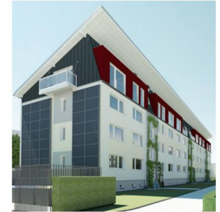
Solarmodule auf Dächern und an der Fassade erzeugen einen Großteil des Stroms, der in den Wohnungen benötigt wird. Damit ist das Gebäude energieautark.
