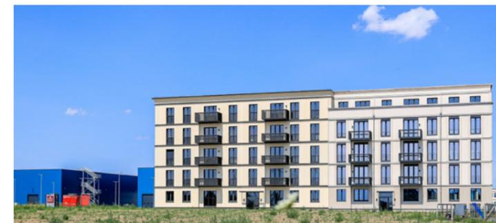
Neben der Produktionshalle steht inzwischen ein fünfgeschossiger Muster-Block, nahezu komplett aus Holzwerkstoffen.
